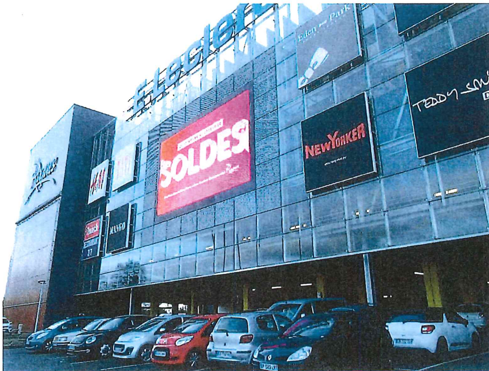
Une enseigne numérique sur un centre commercial (hors de Digne-les-Bains)
