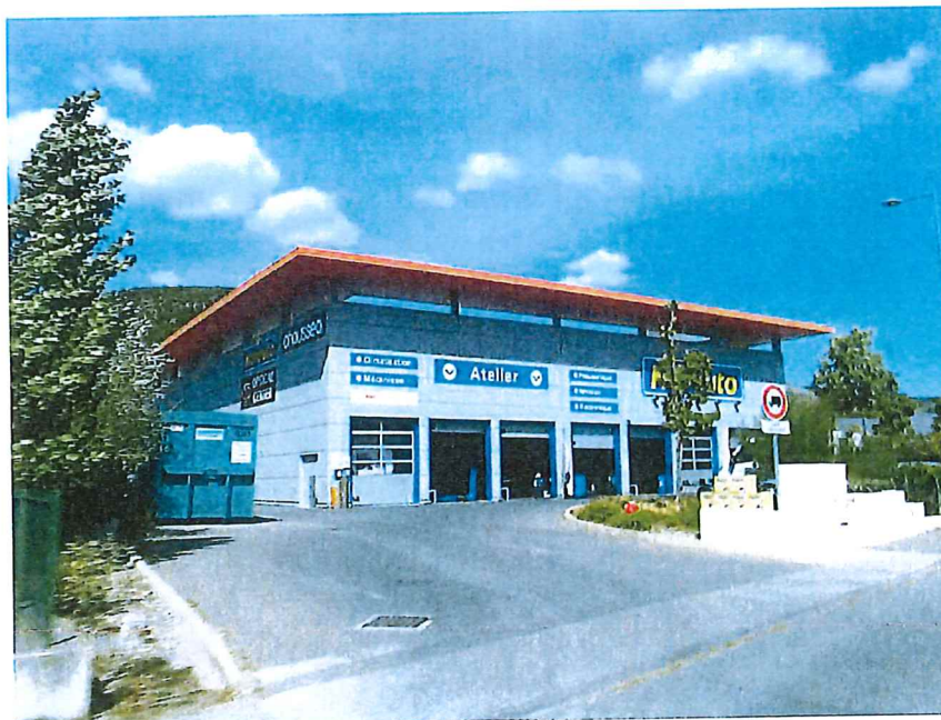
Des enseignes parallèles au mur
