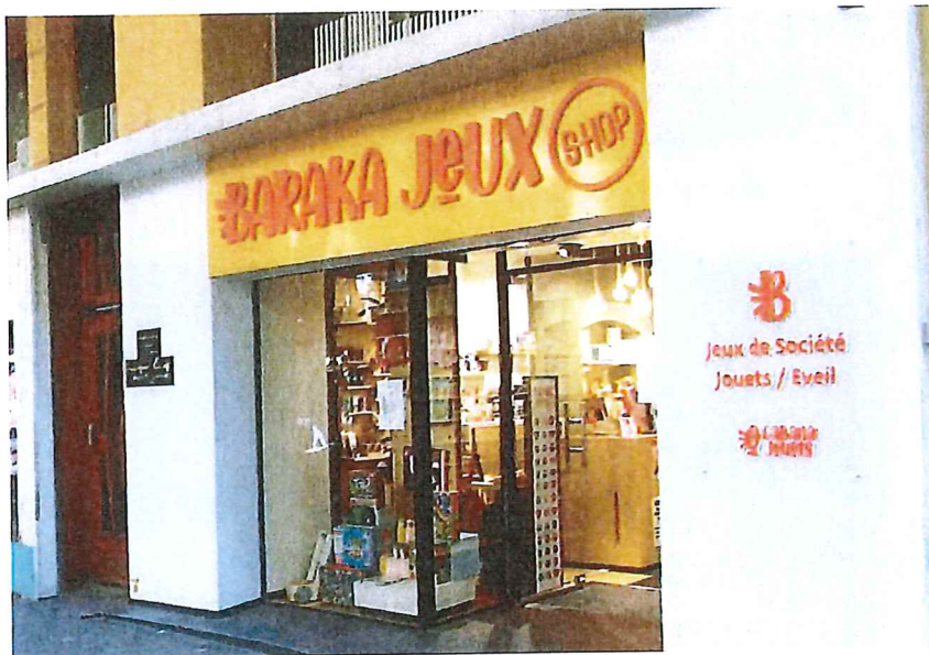
Des enseignes parallèles au mur
