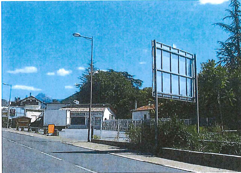
Dos de panneau non habillé
