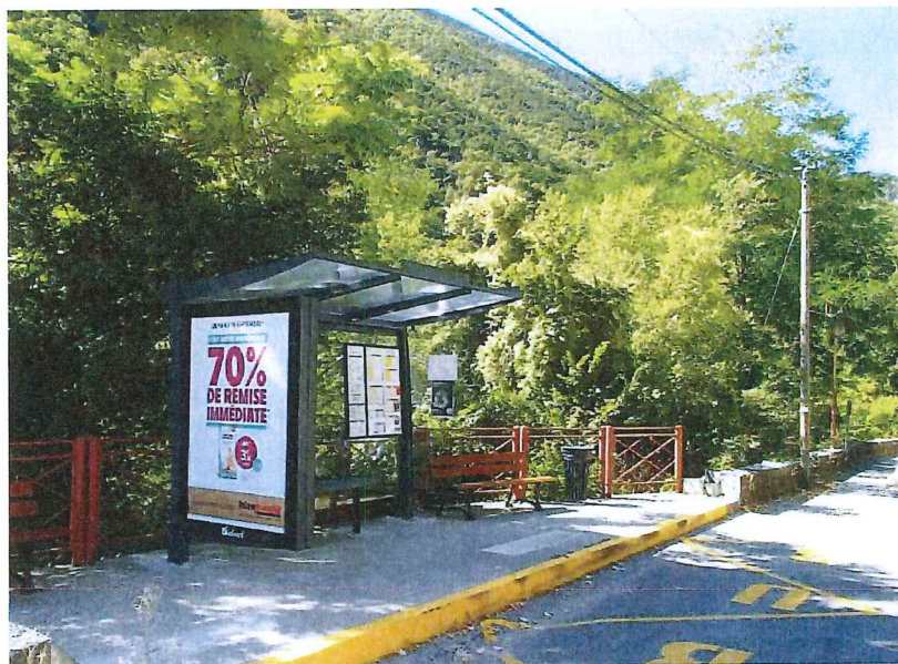
Un abri destiné au public
