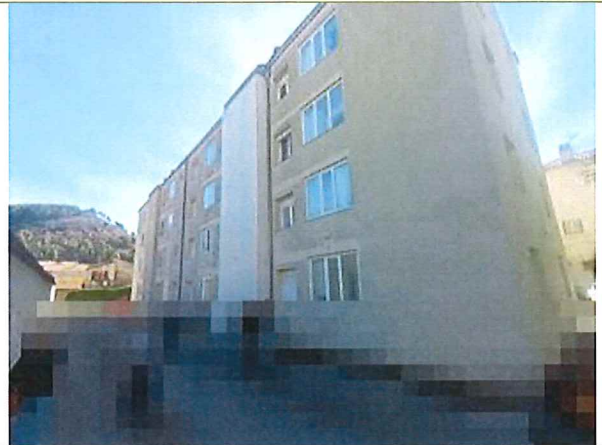
Photo n°3.: Façade Nord en 2024
