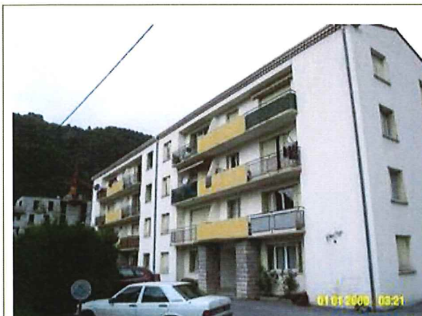
Photo n°1.: Angle Sud-Est de l'immeuble
