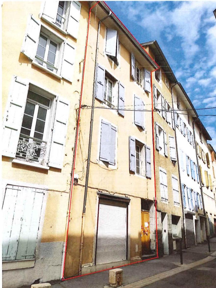
*En rouge la façade SUD-EST de l'immeuble objet du présent rapport depuis la Rue de Provence qui ne présente, visuellement, aucun défaut de stabilité. Nous ne notons la présence d'aucune fissure (autre que fissures superficielles d'enduit de surface).*
