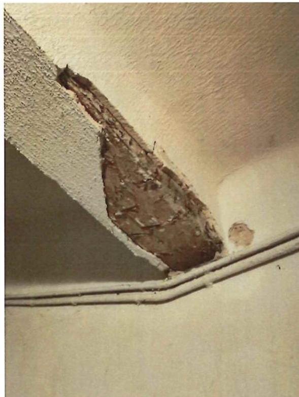
*Vue sur un encrage de poutre supportant les paliers situés au SUD-EST de la cage d'escalier. Ces paliers sont supportés par les murs mitoyens. Après décroutage partiel, ces poutres bois paraissent saines. Ces poutres participent à la stabilité entre les immeubles des parcelles AK 162 - AK 163 & AK 164.*
